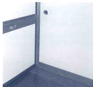
手すりや段差解消の工事もしました（さくらメディカル住宅改修課）
