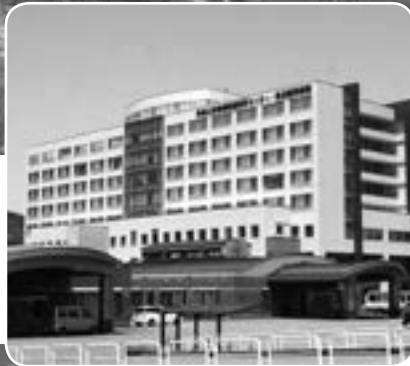
新設の魚沼基幹病院
