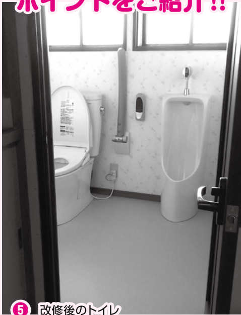
5 改修後のトイレ 広いスペースで介助しやすく
