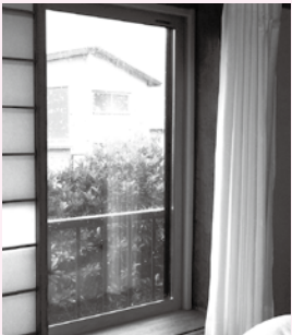
7 冬の寒さに備えて断熱サッシに付け替え
