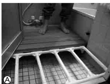
1 洗面場の床に表面が柔らかいスノコを設置して脱衣所との段差を解消する(写真A)。
