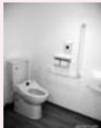
障害者用便器設置。体を手すりに預ける
