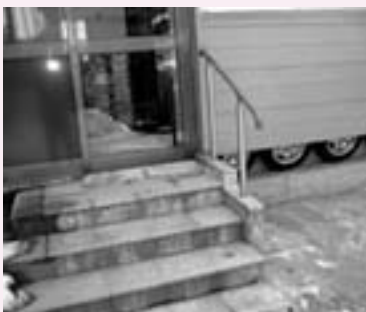
手すりを設置し転倒防止。母も使用
