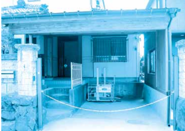
⑦の門扉をとりはずした屋根付きガレージは出入りが便利⑧
